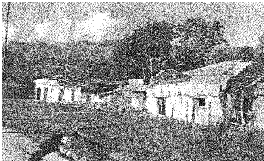
Foto 21 Moyobamba-Azungue: Agrietamiento y viviendas colapsadas en zona de licuación.
