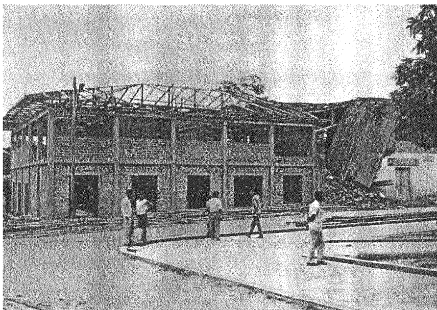
Foto 12 Vivienda de concreto armado en construcción (Soritor)
