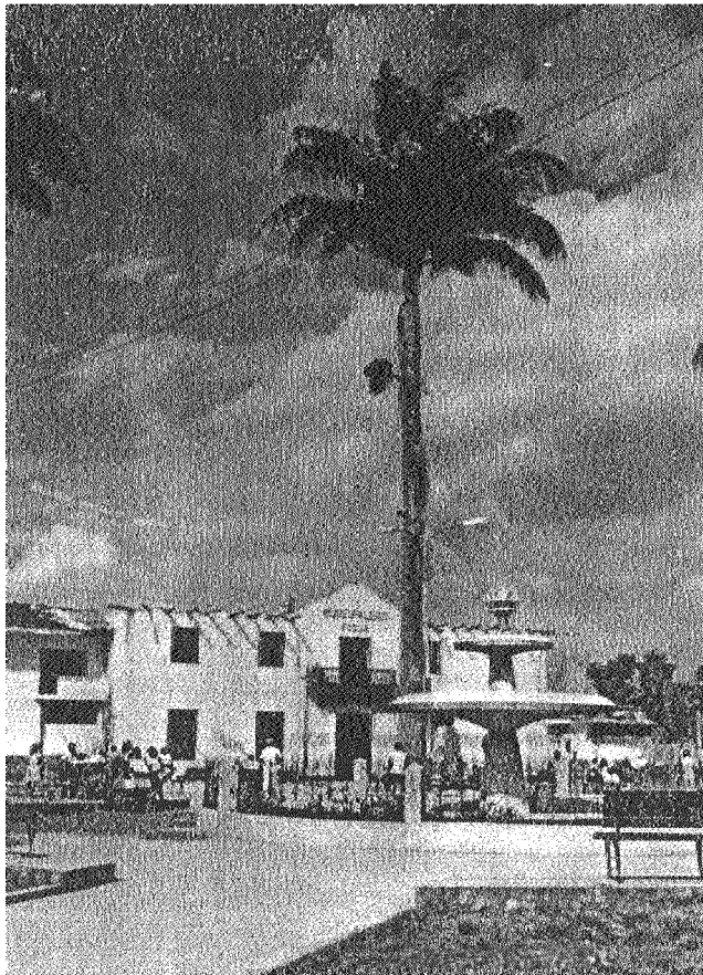
Foto 17 Ciudad de Rioja. Plaza principal-Municipalidad en demolición.
