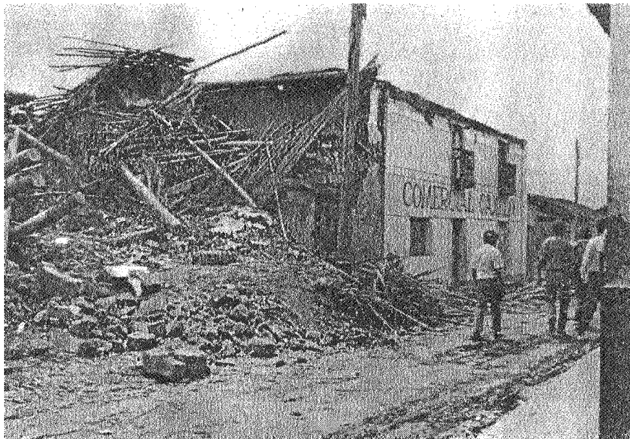
Foto 15 Vivienda de tapial de dos pisos colapsada
